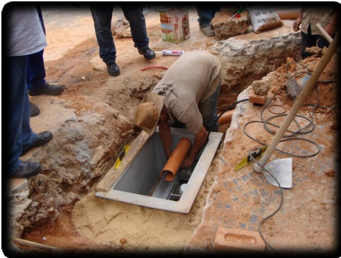
Nivelamento do equipamento
