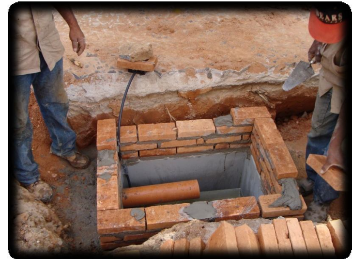
Finalização da caixa de inspeção (instalação da antena)
