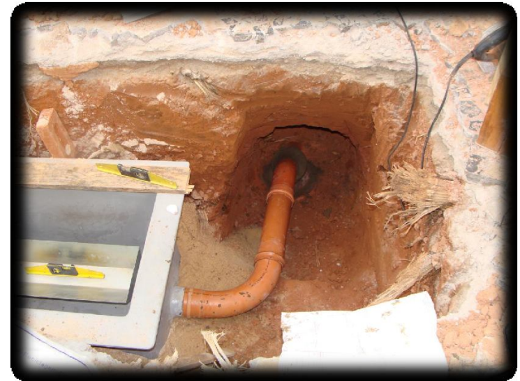
Conexão com a rede de esgoto
