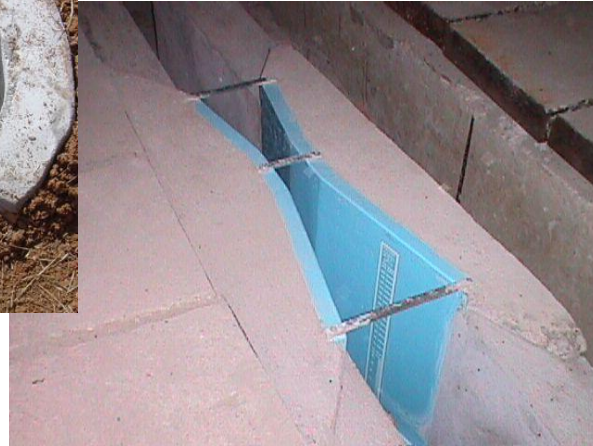
Calha Parshall e Vertedouros
