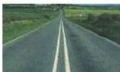
**Asfalto-borracha:** Adição à massa asfáltica de pó de borracha oriundo da trituração de pneus inservíveis. O asfalto-borracha tem uma vida útil maior, além de gerar um nível de ruído menor e oferecer maior segurança aos usuários das rodovias.
